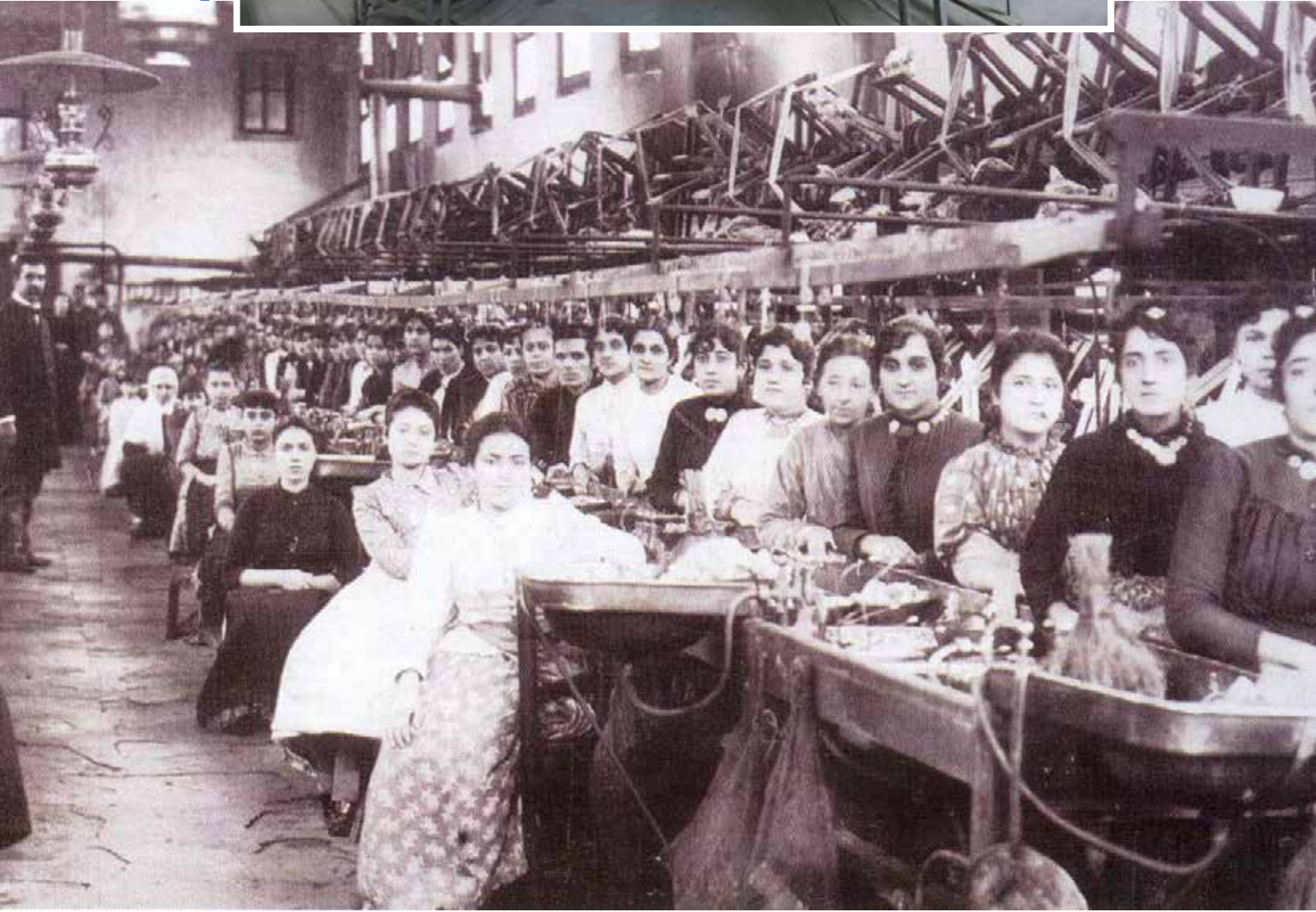
Resim 1.31: Bursa'da ipek çekim fabrikası
